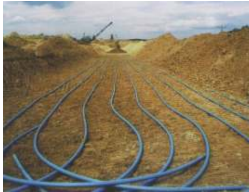
Obr. 18 Ukázka zemního plošného kolektoru
