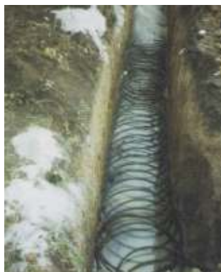
Obr. 19 Ukázka zemního výkopového kolektoru
