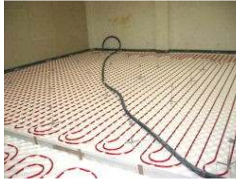
Obr. 3 Systém podlahového vytápění
