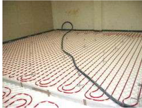
Obr. 3 Systém podlahového vytápění
