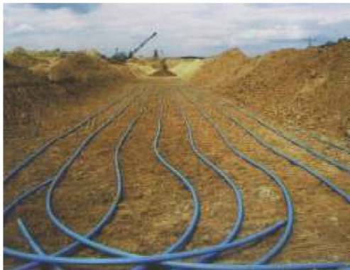
Obr. 18 Ukázka zemního plošného kolektoru
