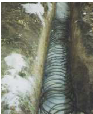
Obr. 19 Ukázka zemního výkopového kolektoru
