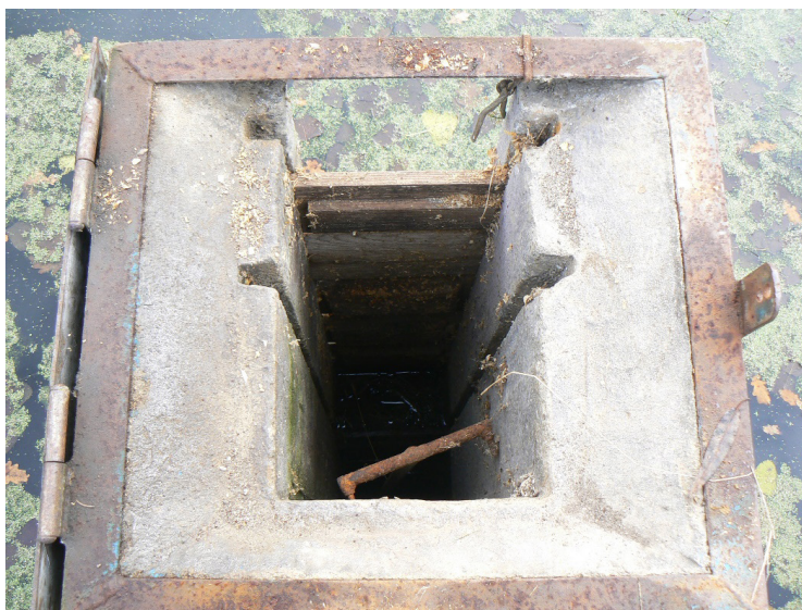
Obrázek č. 4.10 – Pohled do výpustního objektu MVN Koloděje (VD TBD)
