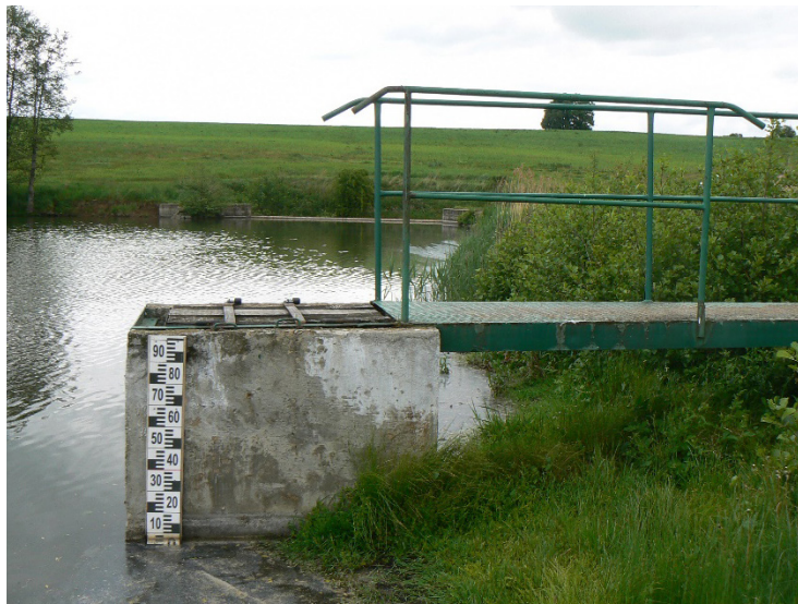
Obrázek č. 4.11 – Pohled na výpustní objekt požeráku na MVN Koloděje s osazeným vodočtem (VD TBD).
