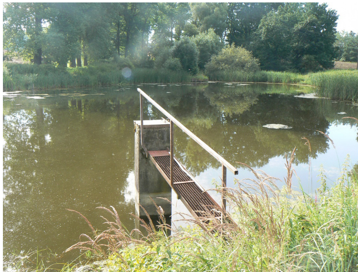
Obrázek č. 4.9 – Pohled na výpustní objekt požeráku na MVN Koloděje (VD TBD)
