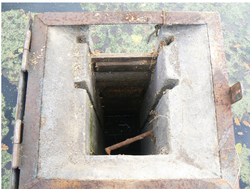
Obrázek č. 4.10 – Pohled do výpustního objektu MVN Koloděje (VD TBD)
