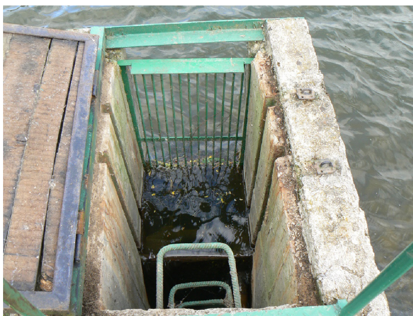
Obrázek č. 4.12 – Pohled na výpustní objekt požeráku na MVN Koloděje s osazeným vodočtem (VD TBD).
