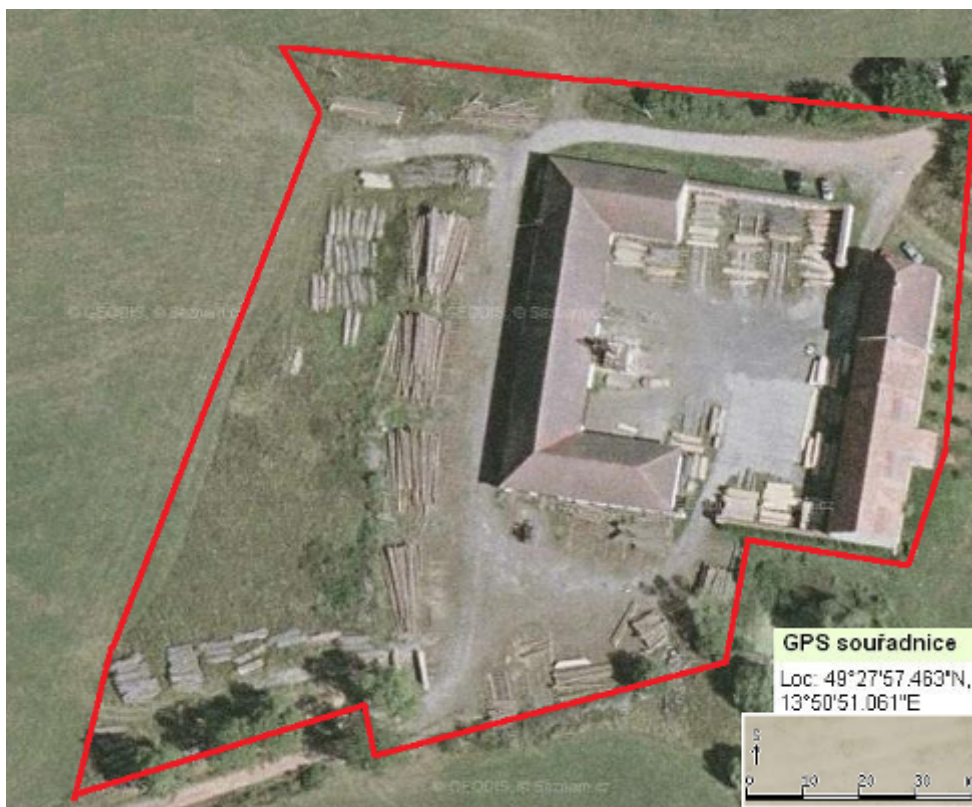
Pila Nový dvůr, Kocelovice 48, 38742 Lnáře
