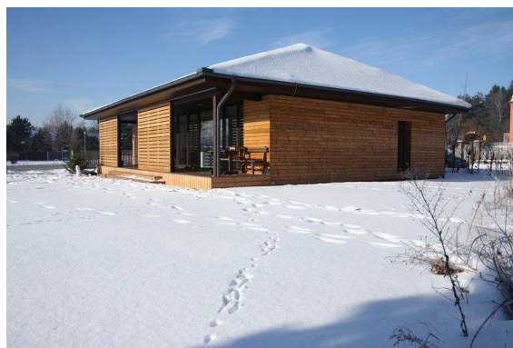
Obrázek 23 – masivní dřevostavba Kompakt II. Zdroj: Dřevo a stavby, 2017
