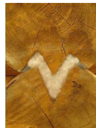
Obrázek 24 – Detail W výřezu. Zdroj: Haniš, 2016
