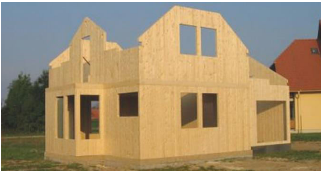
Obrázek 13 – výstavba. Zdroj: Envic, 2011
