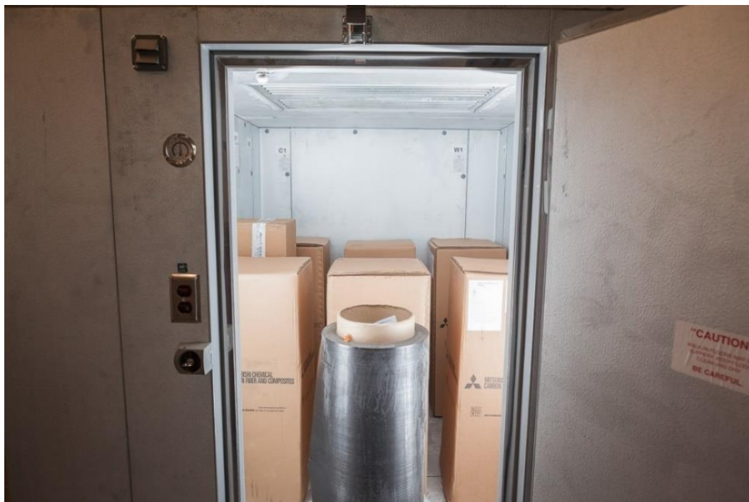
Obr. 38 Chladírenský box pro skladování prepregů [57].
