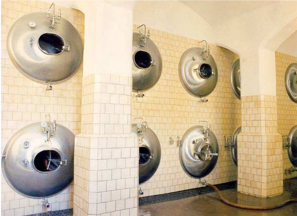
Obr. 2.6 Ležácké tanky v ležáckém sklepě [4]
