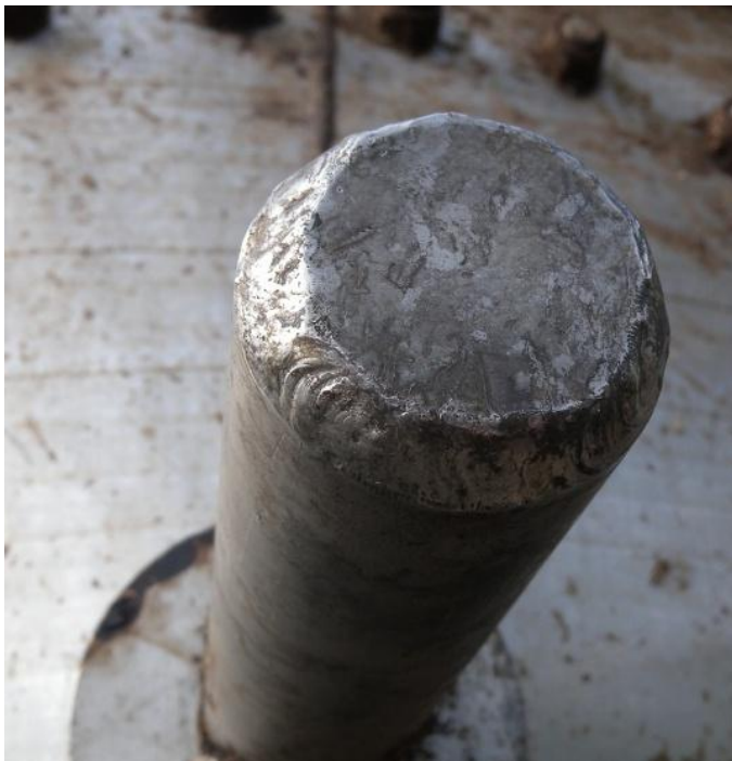
Fotografie č. 5, pohled na koncovou část jímací tyče vynášecí hlavice fermentoru bioplynové stanice s patrným tepelným poškozením nerezové oceli, autor fotografie Martin Petrák, archiv HZS JčK
