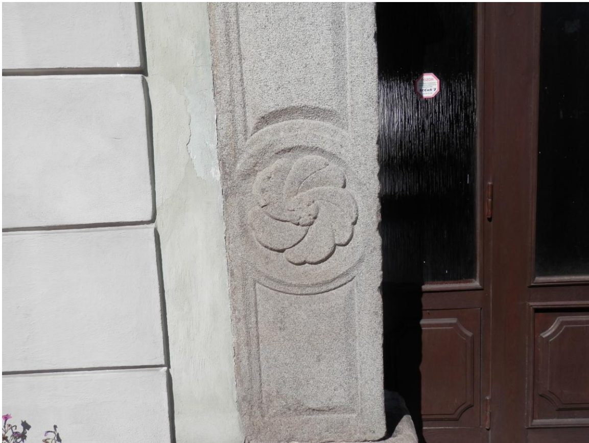
30) Detail portálu radnice, ostění s růžicí
