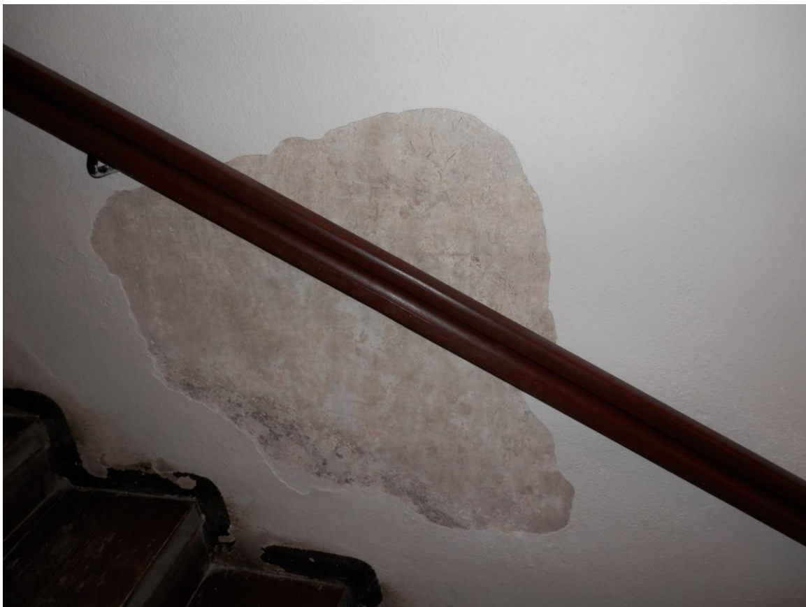
17) Dům čp. 125, odkrytá část zdiva na schodech do 1. patra
