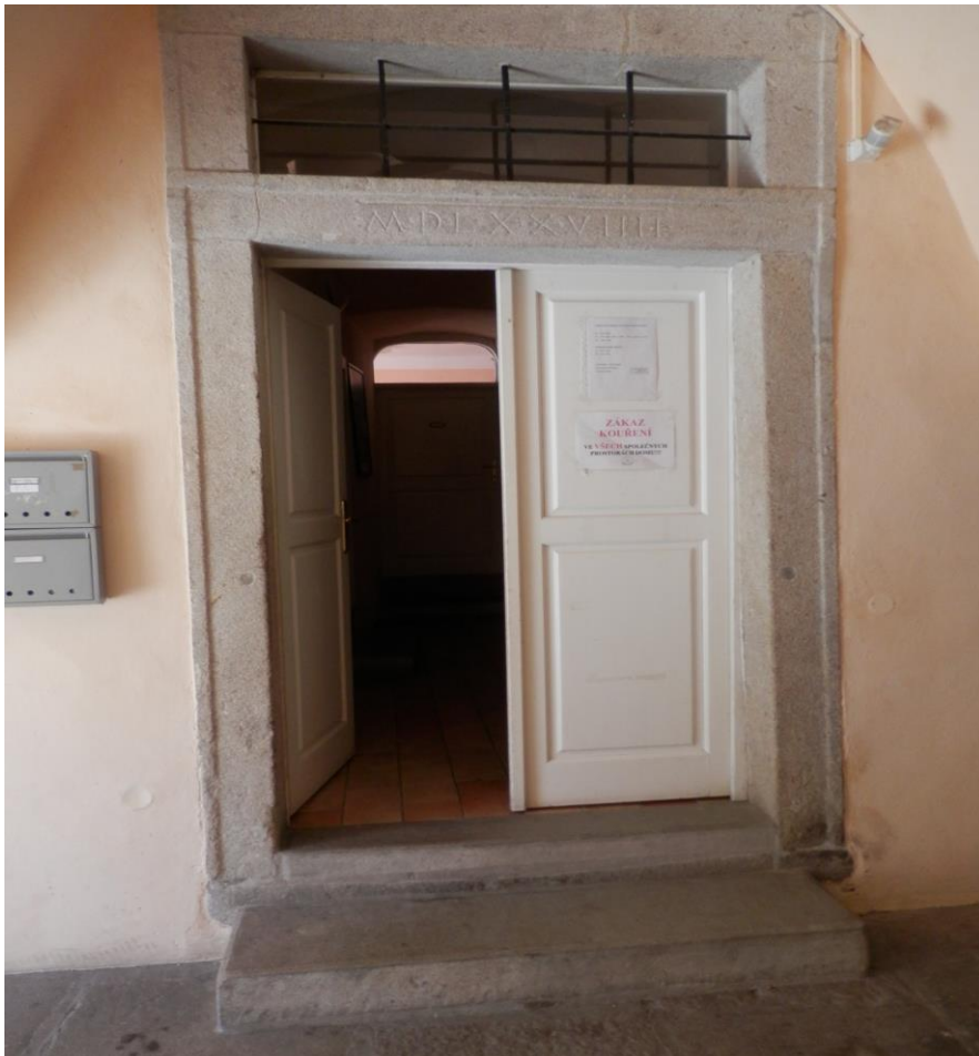
7) Dům čp. 125, vstupní portál v přízemí
