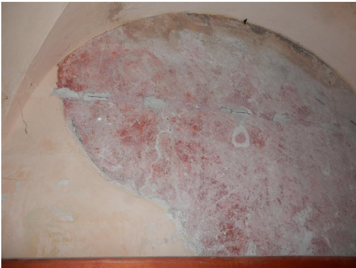
16) Dům čp. 125, odkrytá část zdiva v přízemí
