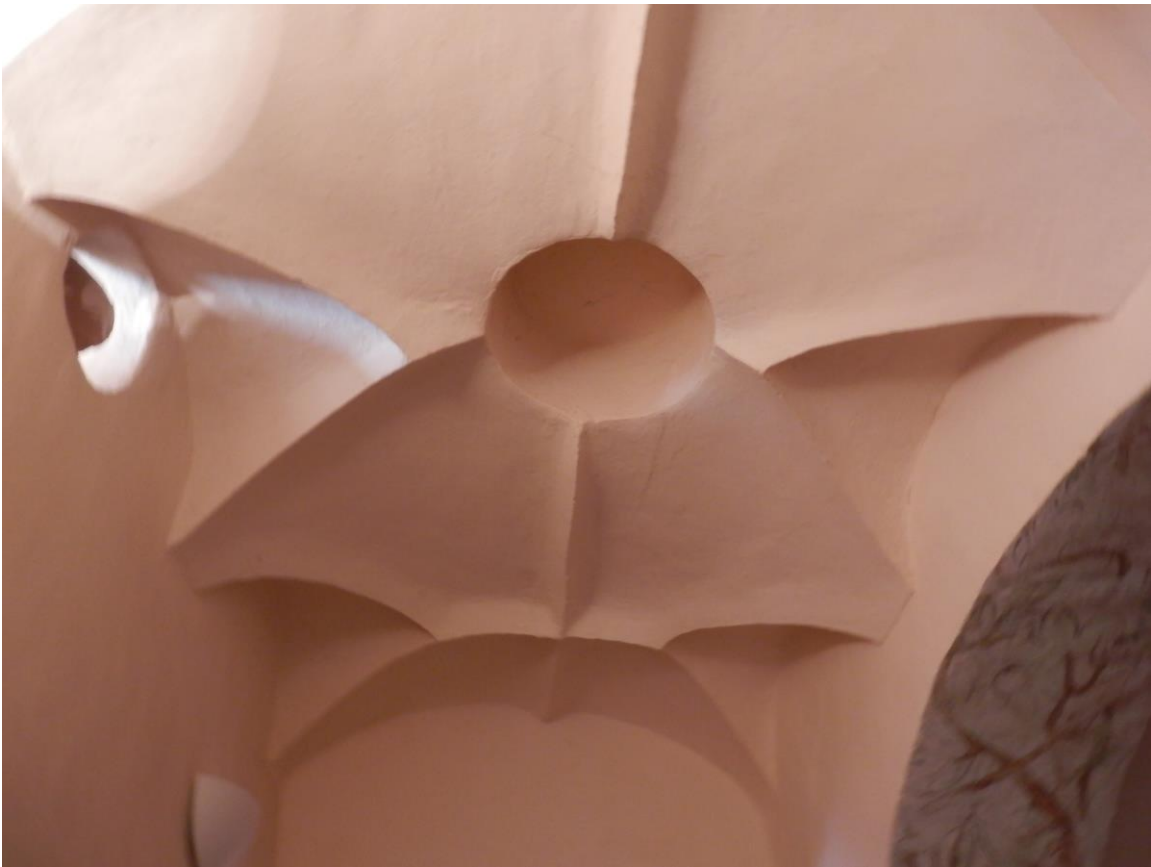
9) Dům čp. 125, sklípková klenba v přízemí
