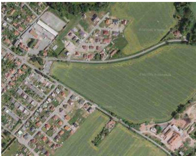
Obr. č. 31 Pohled pohled na IV etapu [4]
