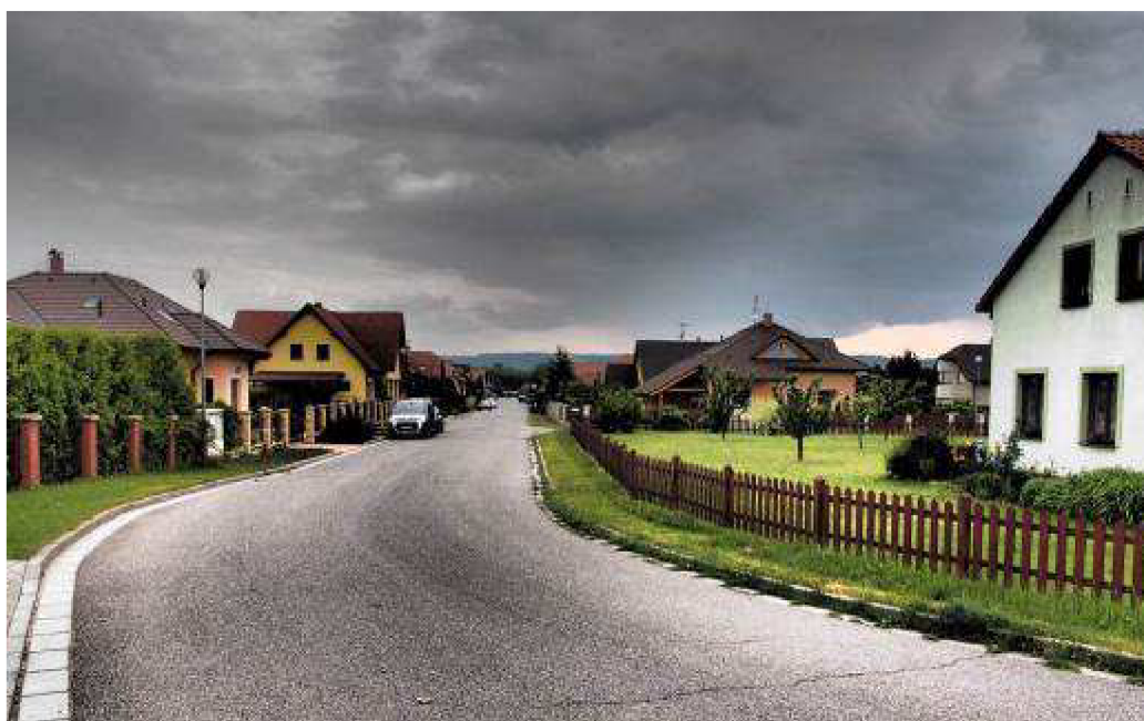
Obr. č. 27 Současný pohled do II etapy ve směru na etapu I
