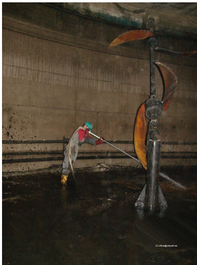
Obr. 3-9: Servisní práce uvnitř vypuštěného fermentoru (Foto: Karl Pfiel)
