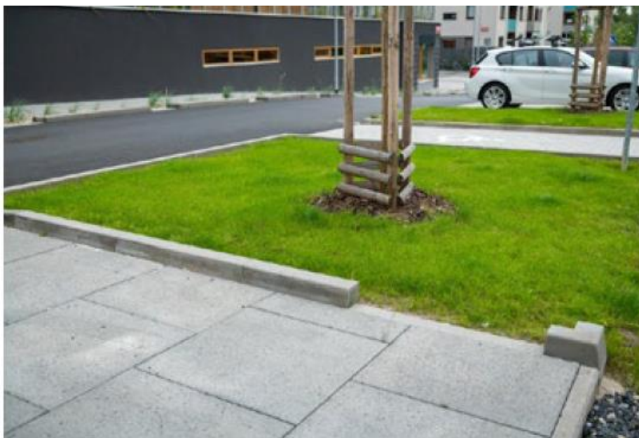
Obrázek 5.8 - Úprava obrubníku pro nátok do plošného vsaku [Voda ve městě, 2021]
