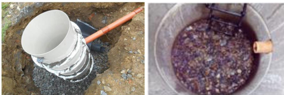
Obrázek 5.14 - Vsakovací šachta [Voda ve městě, 2021]
