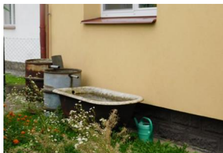
Obrázek 5.20 - Akumulační nádrže [Voda ve městě, 2021]
