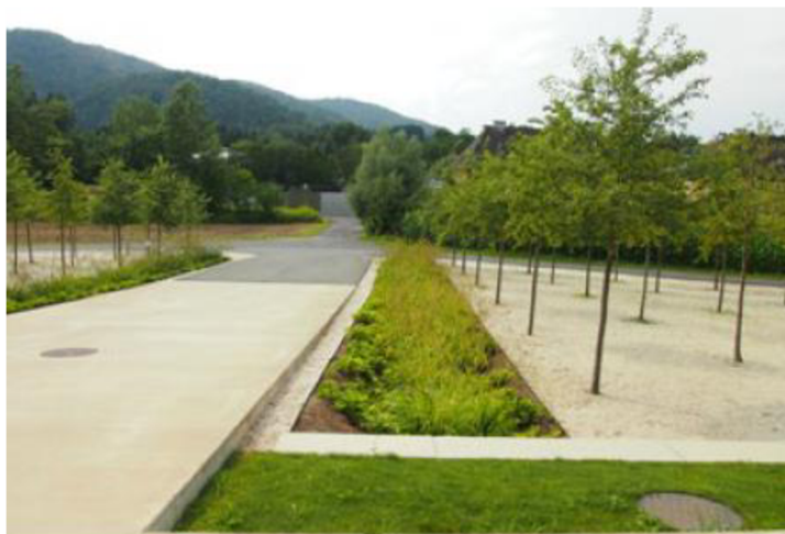
Obrázek 5.10 - Osázený vsakovací průleh [Voda ve městě, 2021]
