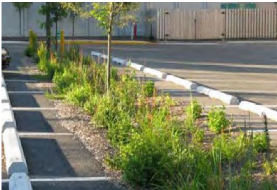
Obrázek 5.12 - Osázená vsakovací rýha s povrchovým přítokem [Voda ve městě, 2021]
