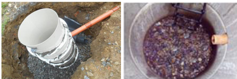
Obrázek 5.14 - Vsakovací šachta [Voda ve městě, 2021]
