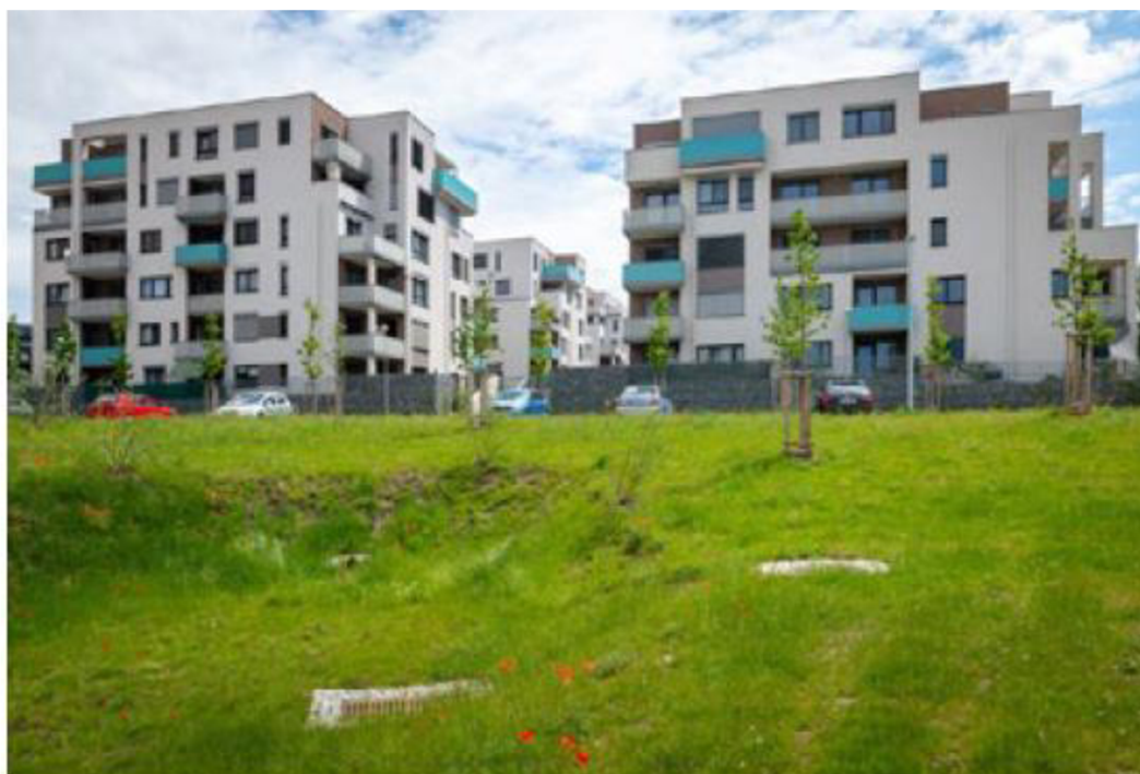
Obrázek 5.16 - Vsakovací retenční nádrž [Voda ve městě, 2021]
