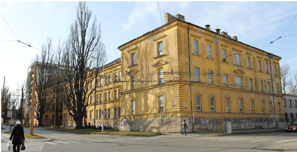
Obr. 8: Štefánikova kasárna, pohled z ul. Vrchlického
