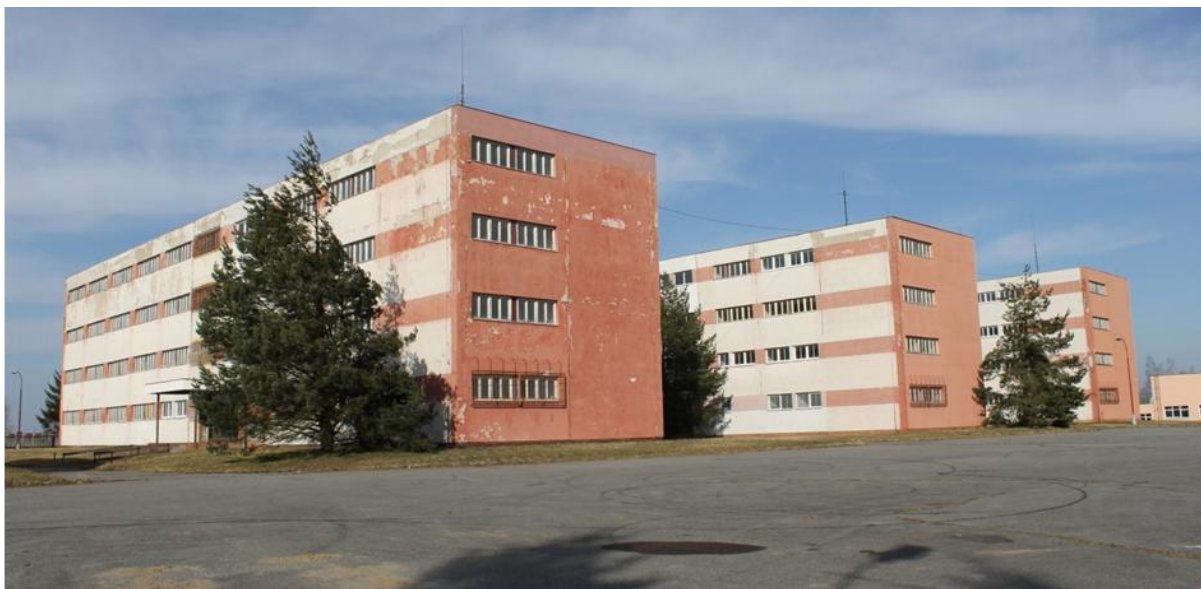
Obr. 6: Ubytovací prostory, Nová kasárna
