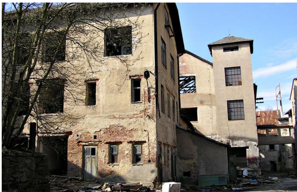
Obr. 11: Komplex průmyslových objektů před rekonstrukcí
