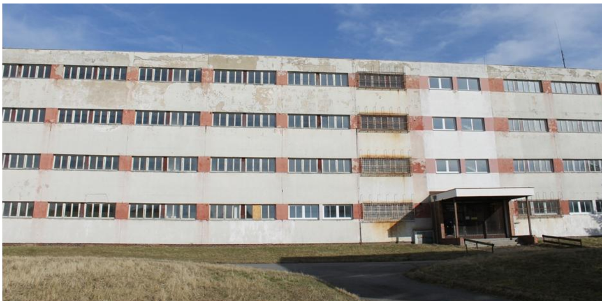
Obr. 7: Ubytovací prostory, Nová kasárna
