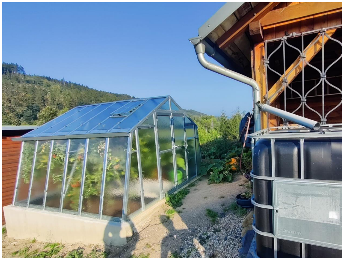
Obr. 28 – Pohled na severovýchodní hranu skleníku v Dlouhé Třebové
