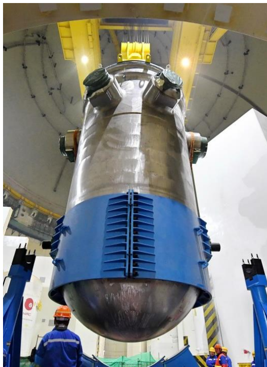
Obr. 2.1 Tlaková nádoba jaderného reaktoru v čínské jaderné elektrárně. [11]
