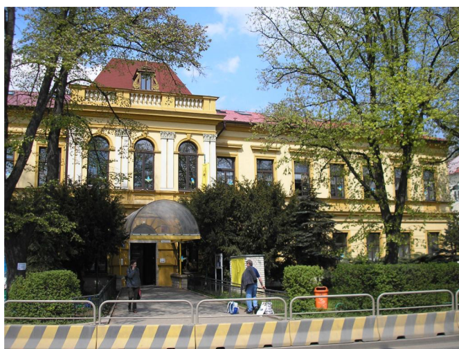
Obrázek 5. Ukázka hlavního vchodu školy ZŠ Bratří
