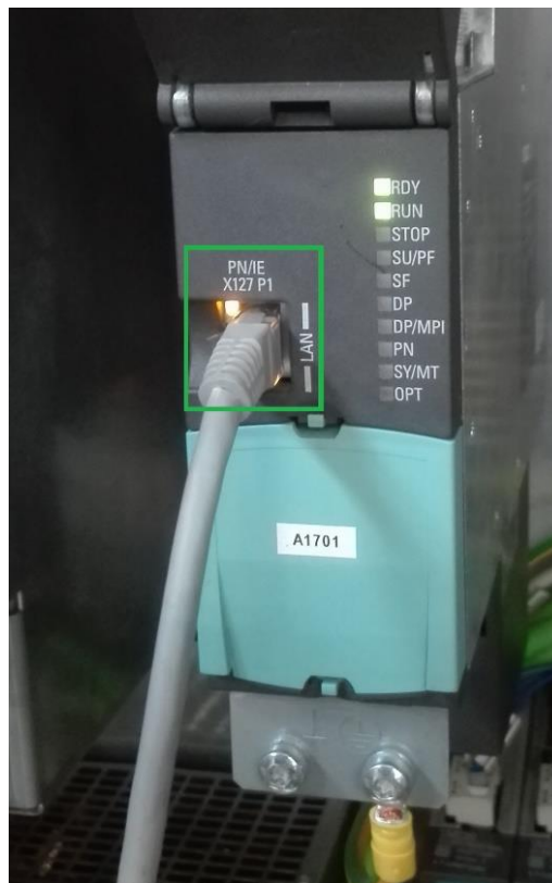
Obr. 9) Realizace zapojení Ethernetového kabelu
