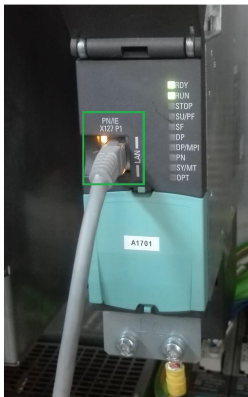
Obr. 9) Realizace zapojení Ethernetového kabelu
