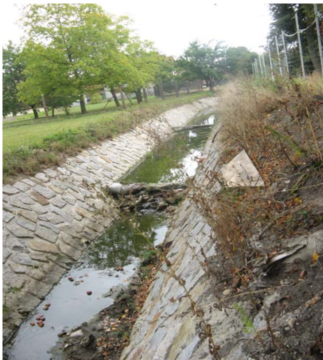
Foto 2: Koryto lichoběžníkového tvaru, relativně silně zahloubené, s úpravami dna i břehů (kamenná dlažba), přítomny jsou i stupně. Černá Strouha v obci Svatá Kateřina.
