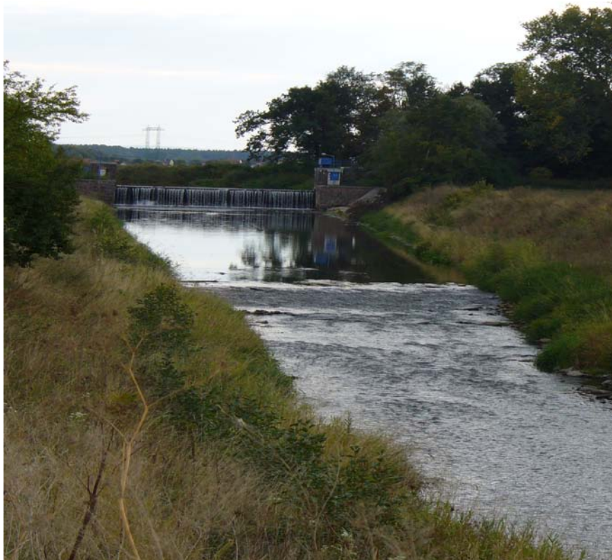
Foto 3: V popředí nízký stupeň; v pozadí velmi vysoký stupeň s nulovou prostupností pro ryby
