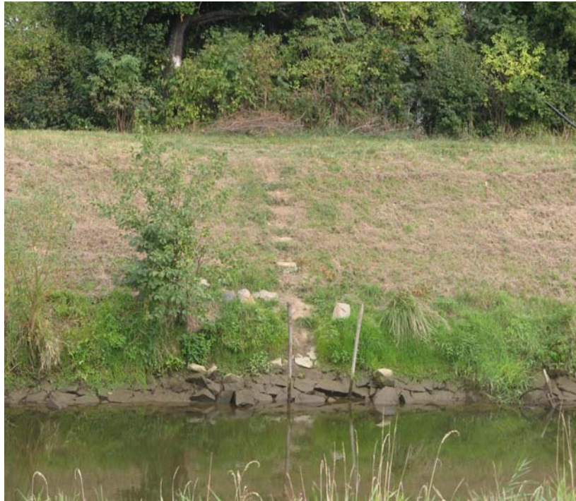
Foto 4: Silně zahloubený vodní tok, s technickou břehovou úpravou lomovým kamenem
