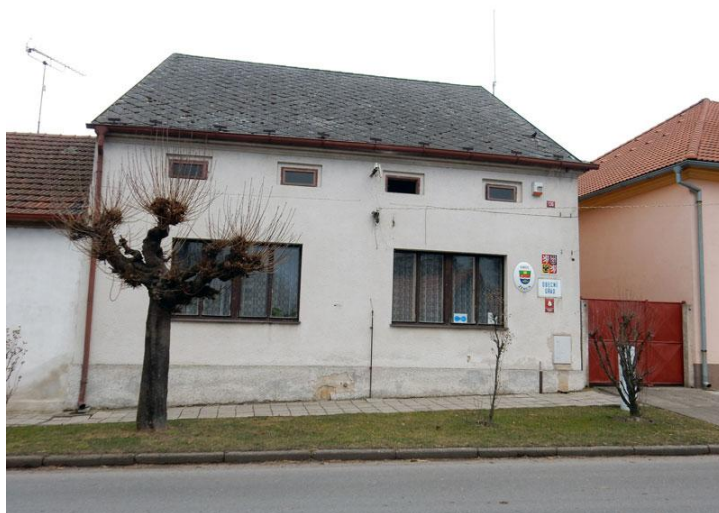
Obrázek 8 Budova obecního úřadu před plánovanou rekonstrukcí
