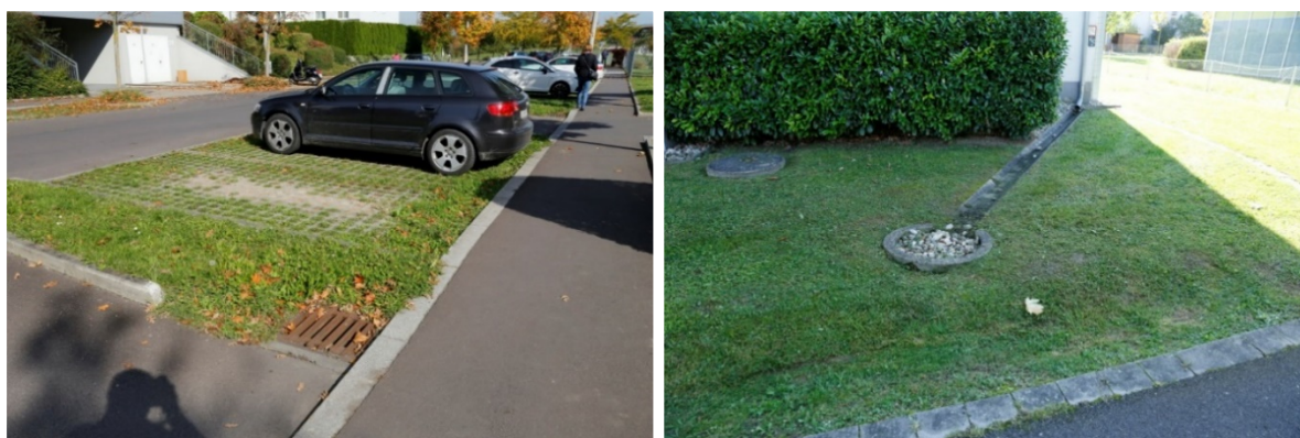
Obr. 8.7 Parkovací stání ze zatravněvacích tvárnic (vlevo) a zaústění dešťového svodu (vpravo) v SolarCity Linz [71]
