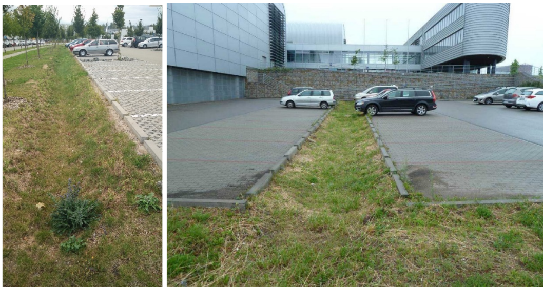
Obr. 5.25 Vsakovací průlehy v kombinaci s řešením odvodnění zpevněné plochy pomocí mezer mezi obrubníky v areálu Ceitec v Brně (vlevo) [vlastní] a v kampusu MU v Brně (vpravo) [8]
