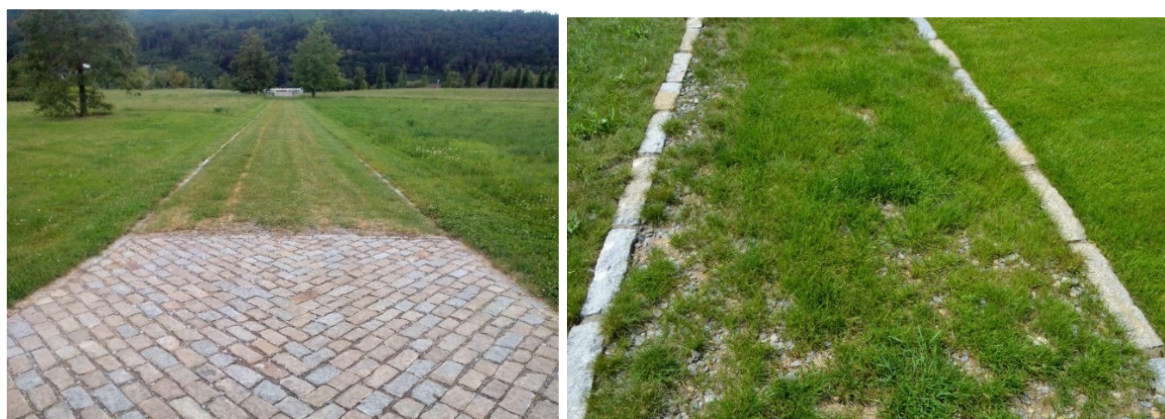
Obr. 5.20 Přechod z dlažby do štěrkového trávníku (vlevo) a štěrkový trávník v roce výsadby (vpravo) [80]
