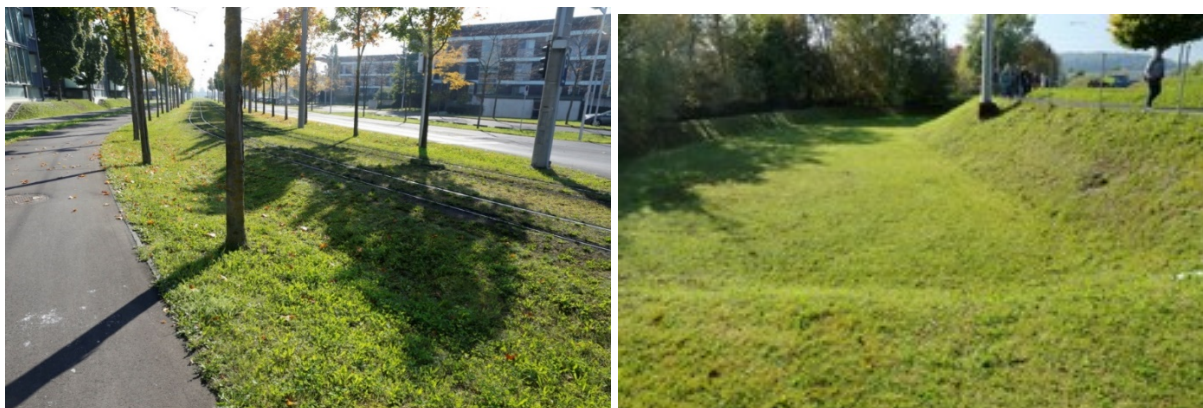
Obr. 8.6 Vsakovací průleh (vlevo) a vsakovací nádrž (vpravo) v SolarCity Linz [71]
