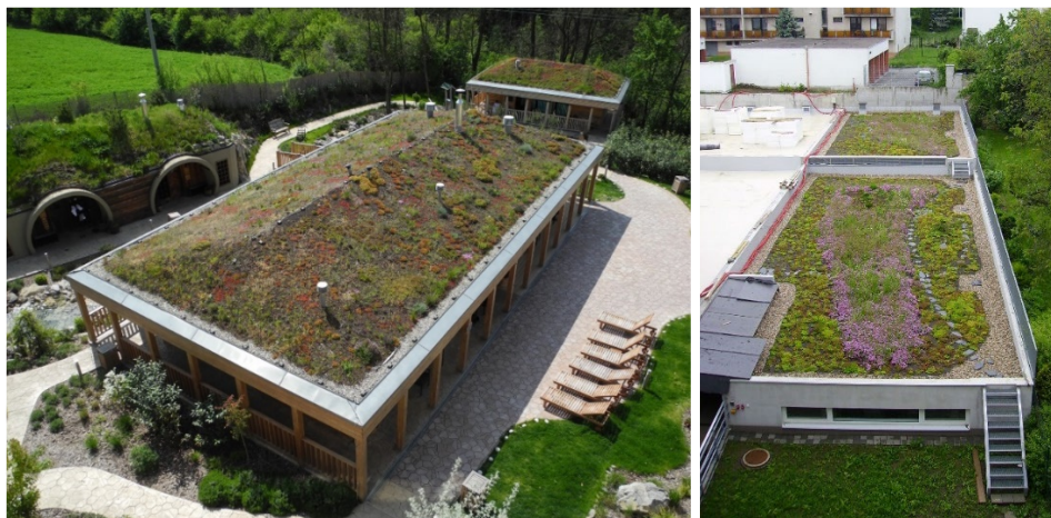
Obr. 6.7 Extenzivní zelená střecha v areálu wellness resortu Infinit Maximus (vlevo) a extenzivní zelená střecha s luční výsadbou (vpravo) [105] [106]
