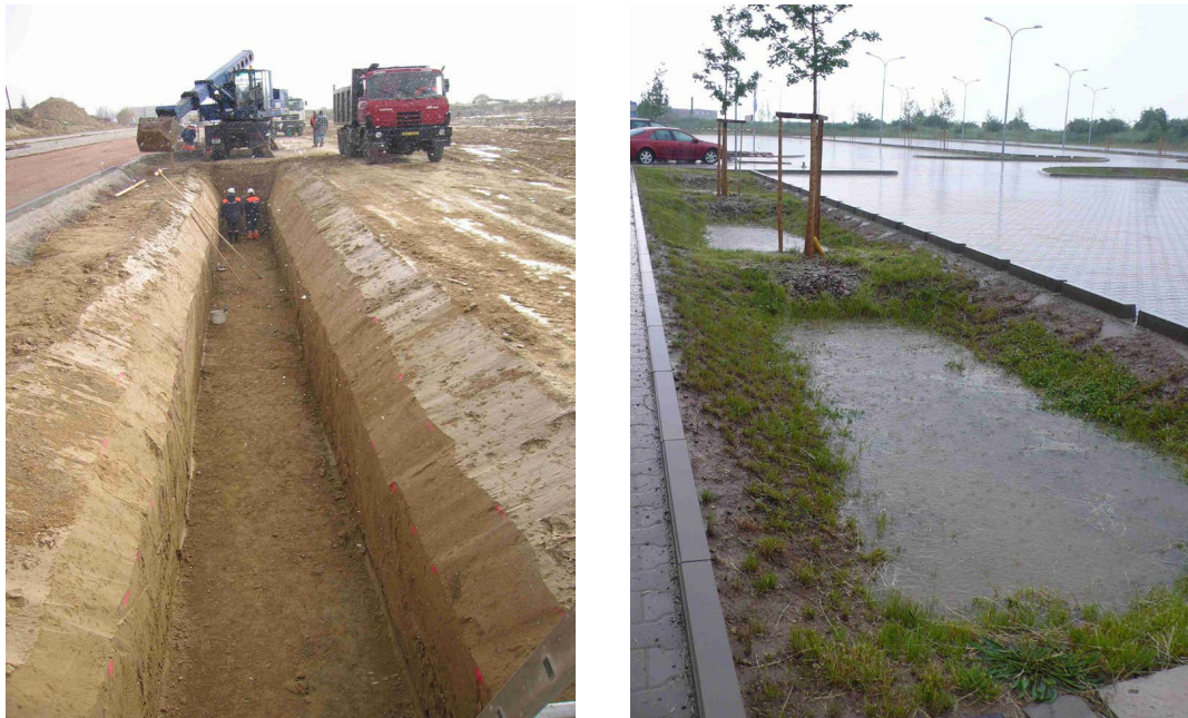
Obr. 8.1 Odvodnění parkoviště vsakovacím průlehem s retenční rýhou [117]
