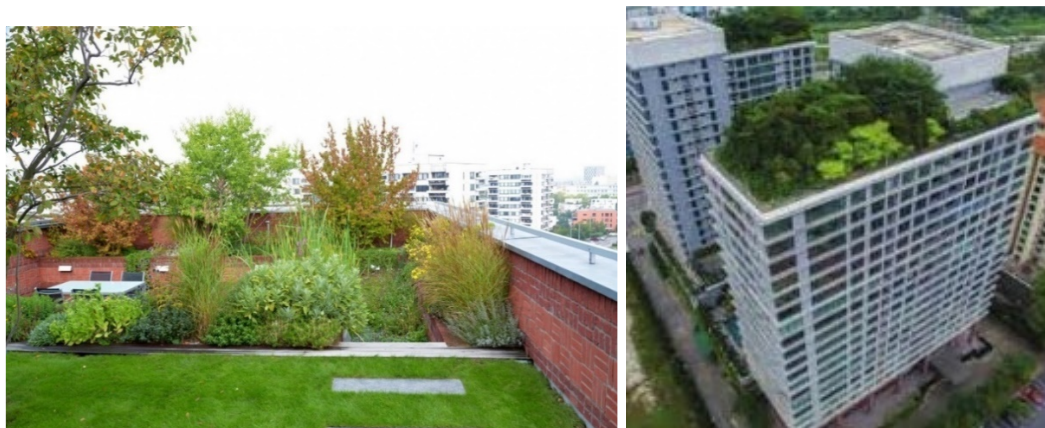
Obr. 6.8 Intenzivní zelená střecha bytového domu [105] [107]
