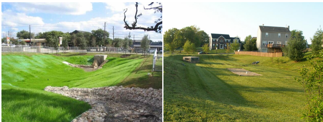
Obr. 5.11 Suché retenční dešťová nádrž [65] [66]
