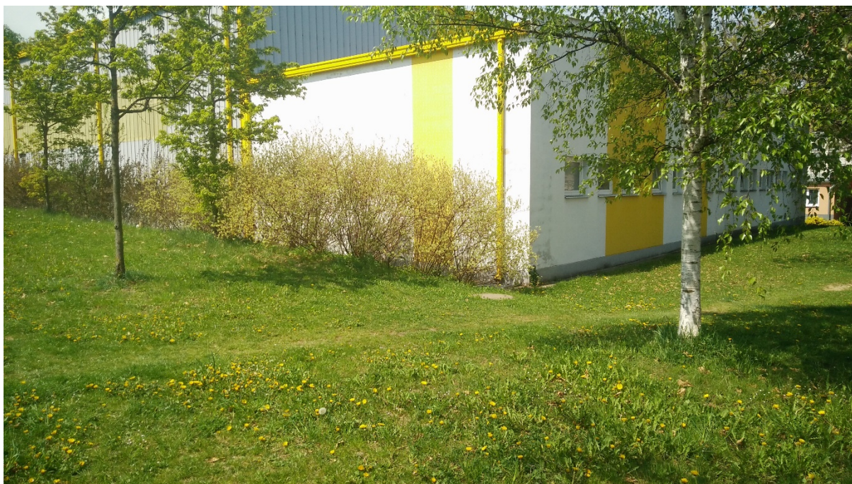
Obr. 9.28 Vhodné místo pro umístění podzemního vsakovacího objektu VS10 [vlastní]
