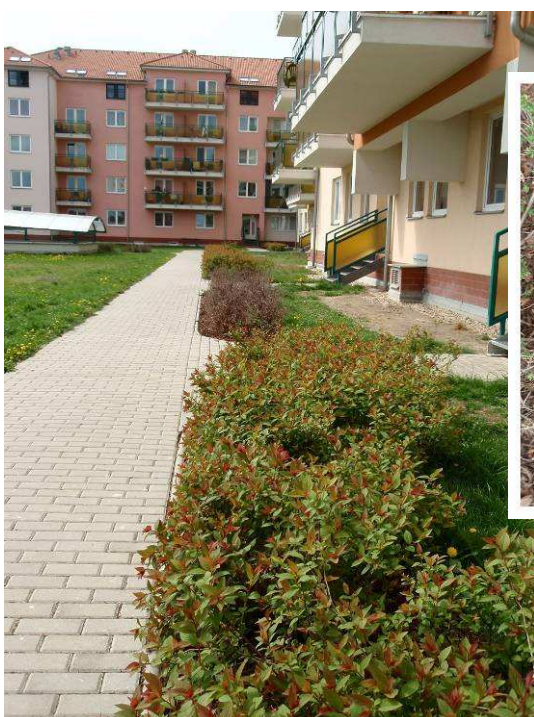
Obr. 31: Pohled 3 (vlastní foto, 21.4.2010)
