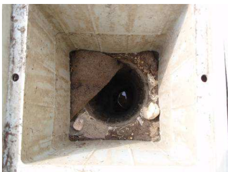
Obr. 35: Správně vypadající kontrolní šachta (vlastní foto, 21.4.2010)
