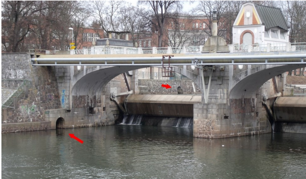
Obr. Hu 1 – Pohled na RP (označen šipkami) na jezu Hučák, který je zasazen do pravého břehového tělesa
