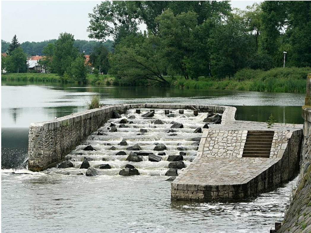
Obr. O-4 – Migrační rampa zbudovaná v Břeclavi na řece Dyji [1]
