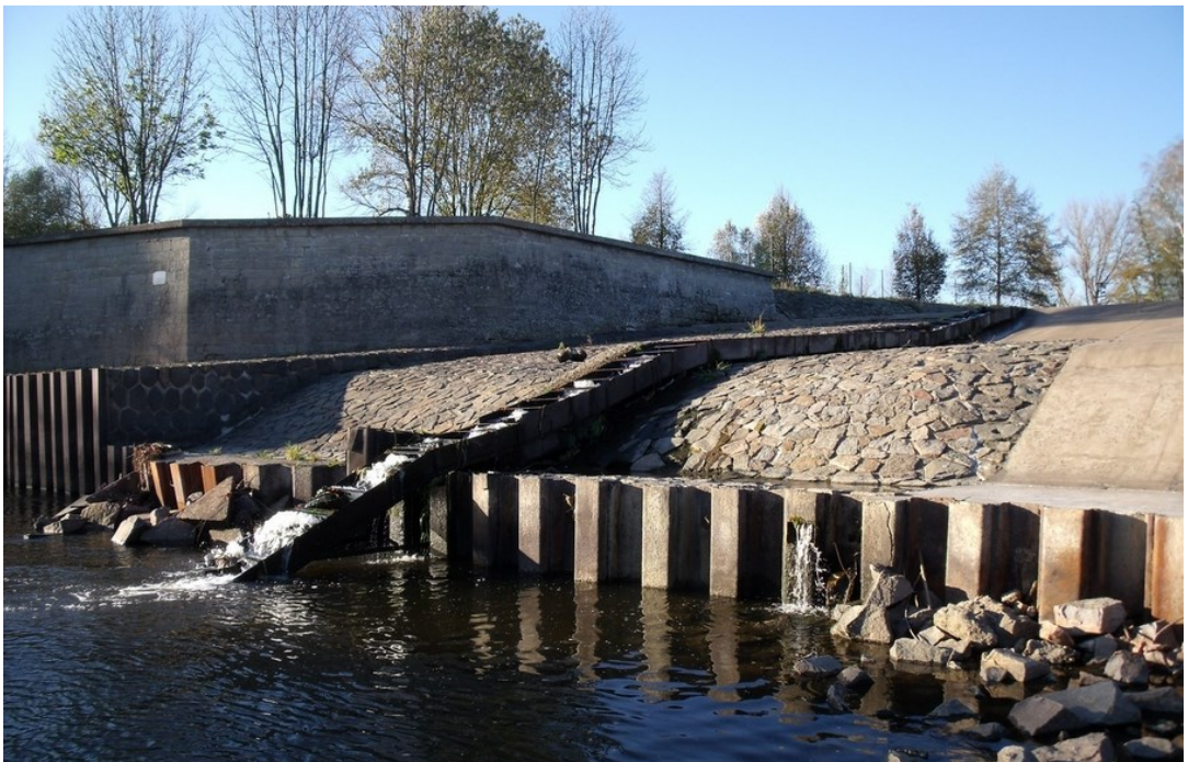
Obr. Op 2 – Přílišný spád spodní části RP na Opatovickém jezu
