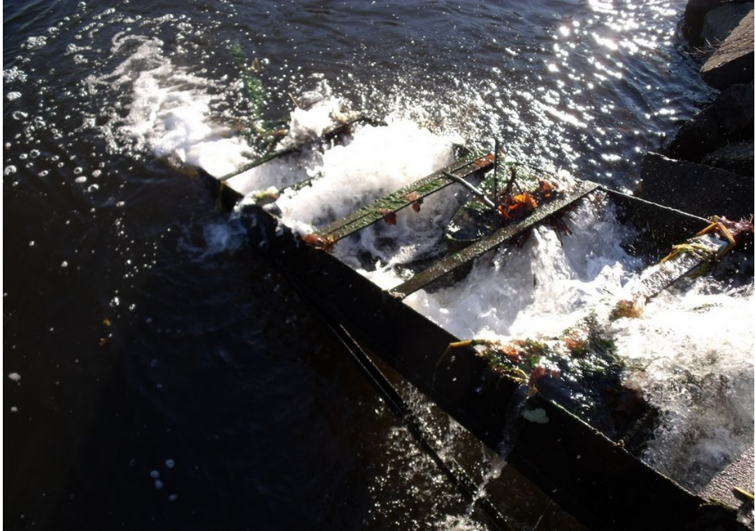
Obr. Op 3 – Zanešení trati RP na Opatovickém jezu splávím
