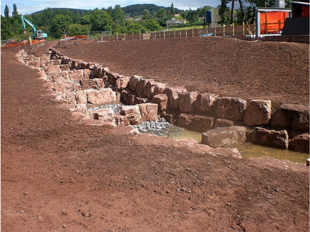
Obr. O-3 – Fotografie budovaného tůňového rybího přechodu [6]
