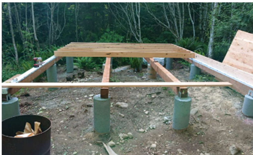
Obrázek 16: Založení stavby na pilířích
