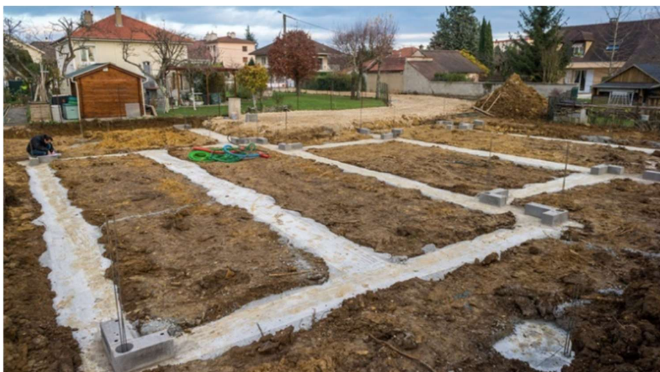
Obrázek 15: Zakládání domu na betonové pasy
