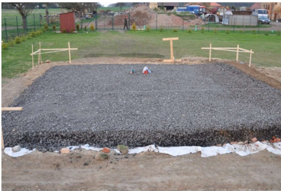
Obrázek 17: Založení stavby na pěnovém skle
