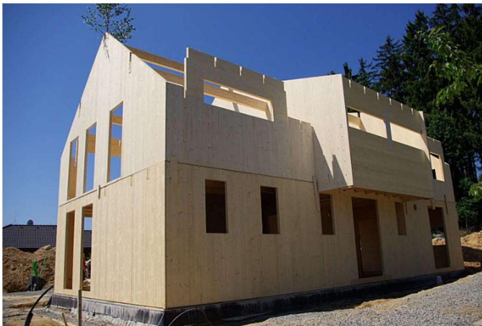
Obrázek 4: Stavba z CLT panelů
