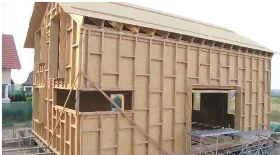
Obrázek 21: Rámová konstrukce během výstavby
