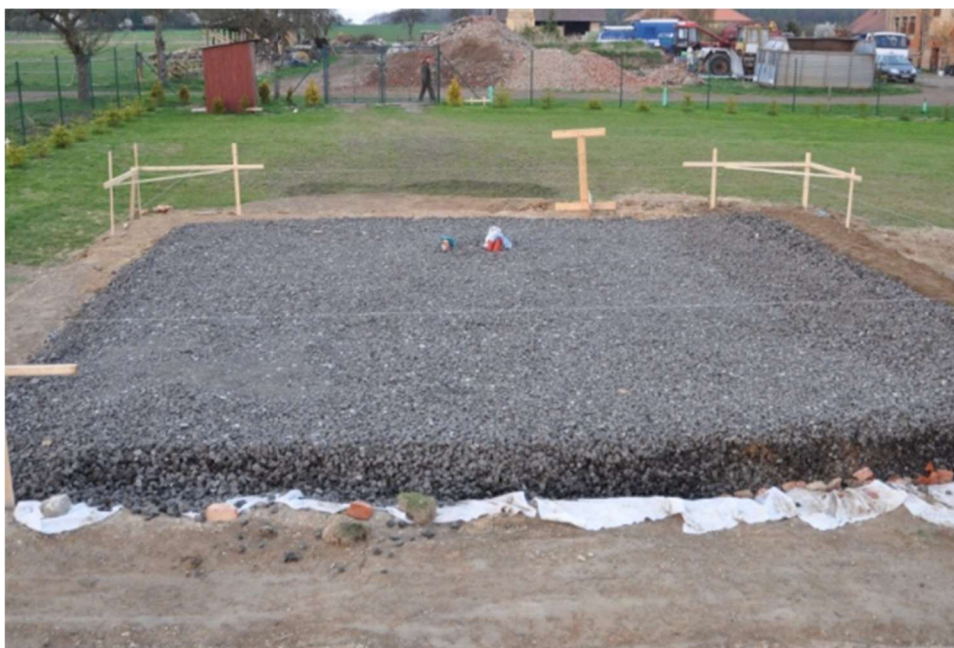
Obrázek 17: Založení stavby na pěnovém skle
