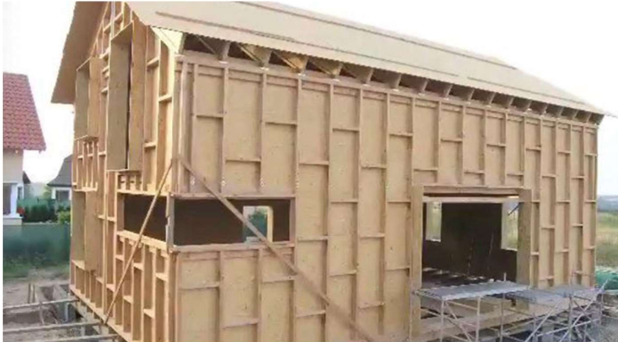
Obrázek 21: Rámová konstrukce během výstavby
