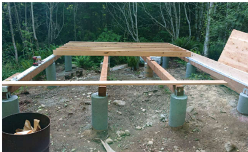
Obrázek 16: Založení stavby na pilířích
