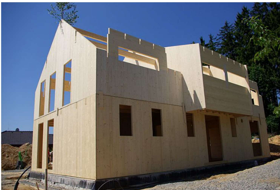
Obrázek 4: Stavba z CLT panelů
