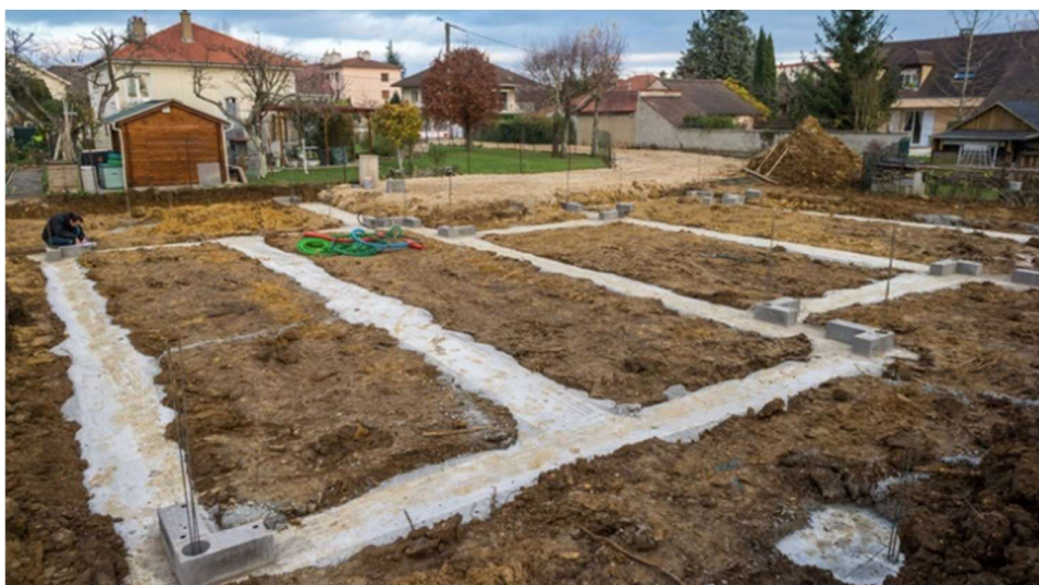
Obrázek 15: Zakládání domu na betonové pasy
