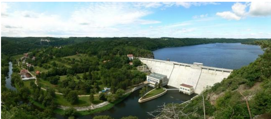
Obr.14: Vranovská víceúčelová přehradní nádrž, Zdroj: http://www.ubytovani-vranov.info/informace-pro-turisty/vranovska-prehrada/
