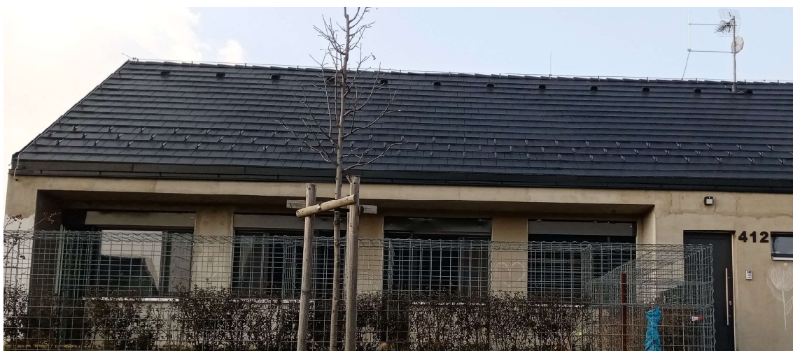
Obr. 9: Dům č.p. 412 s atypickým zápražím na jižní straně domu.
