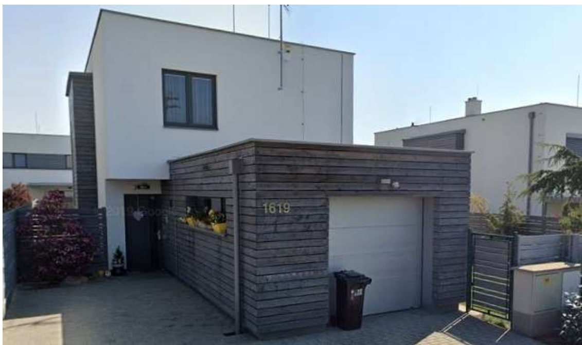
Obr. 21: Dům č.p. 1619 s rozdílným půdorysem přízemí a 1. podlaží – 1. pohled severozápadní strana.
