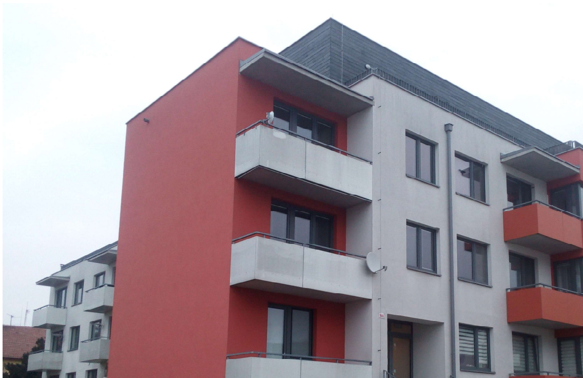
Obr. 32: Bytový dům č.p. 1602 a č.p. 1603 – jihozápadní roh.
