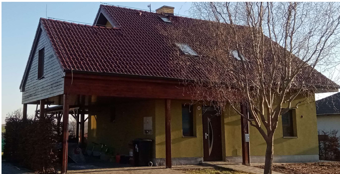
Obr. 18: Dům č.p. 390 s rozdílným půdorysem přízemí a podkroví.
