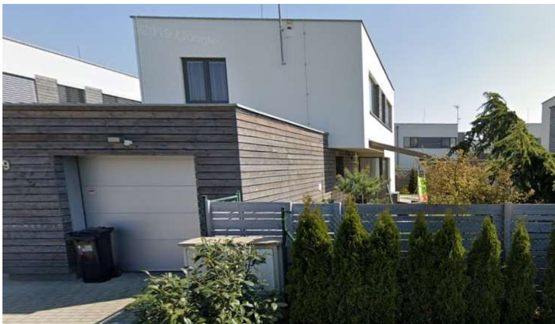
Obr. 22: Dům č.p. 1619 s rozdílným půdorysem přízemí a 1. podlaží – 2. pohled jihozápadní strana.
