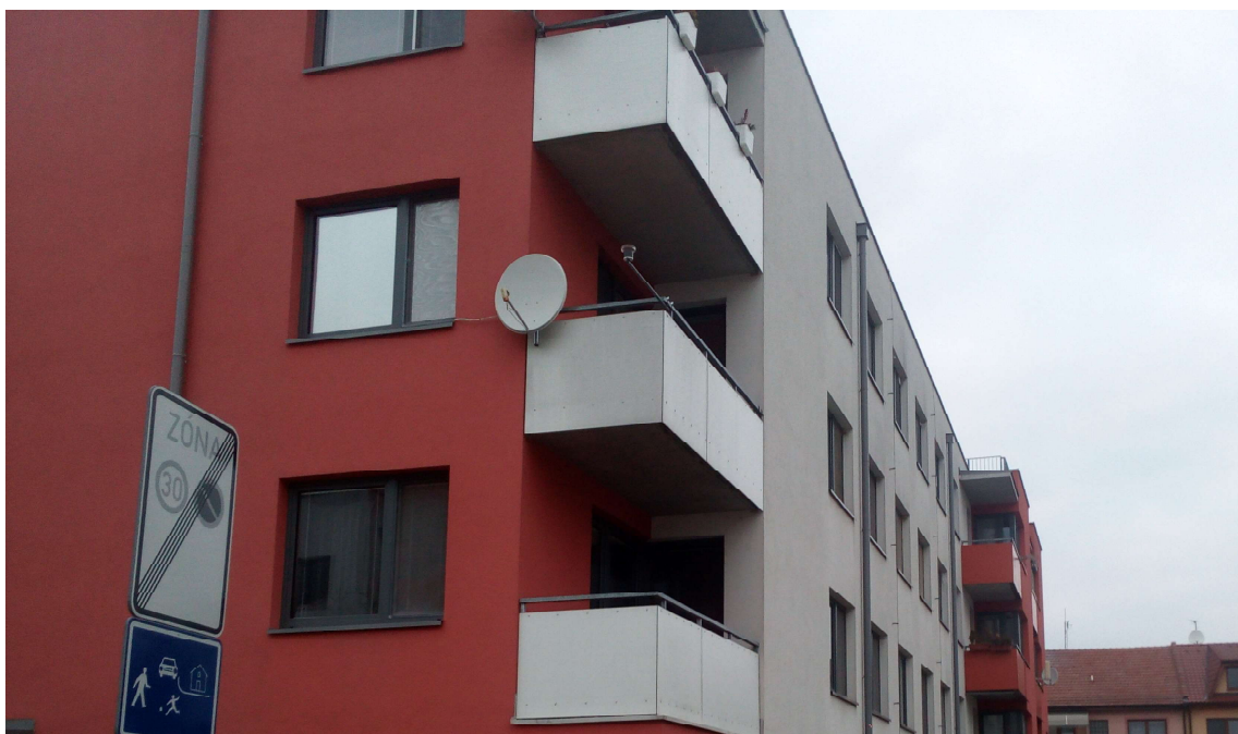
Obr. 33: Bytový dům č.p. 1602 a č.p. 1603 – jihovýchodní roh.
