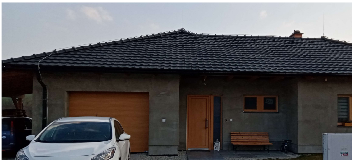
Obr. 15: Dům č.p. 422 s atypickým zasunutým vstupem do budovy.
