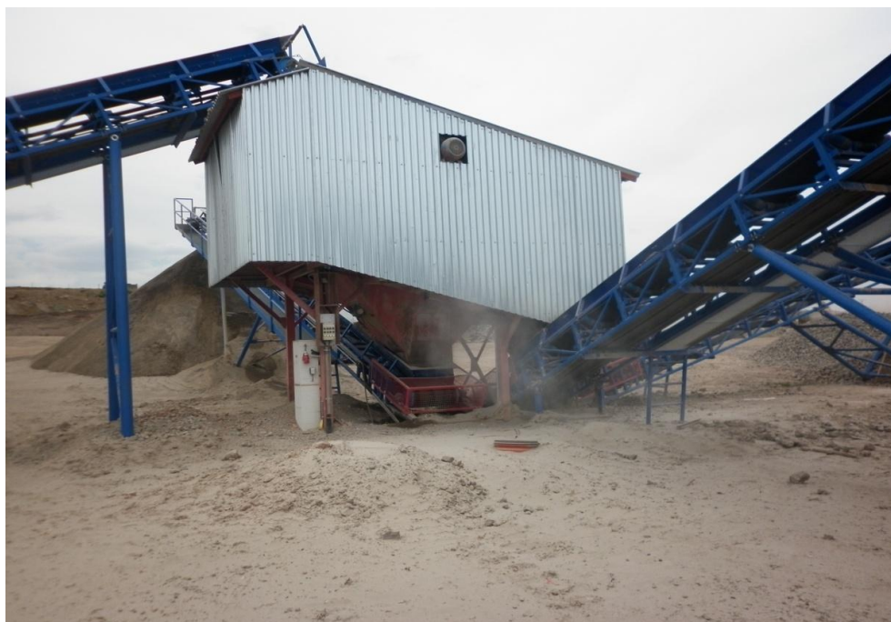
Obr. č. 11 Zakrytování technologických uzlů a dopravníků recyklační linky (Tomšíková, 2015)
