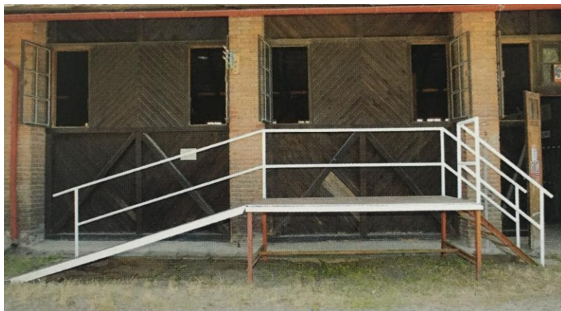
Obrázek 1 Rampa pro vozíčkáře (Hermannová et al. 2014)
