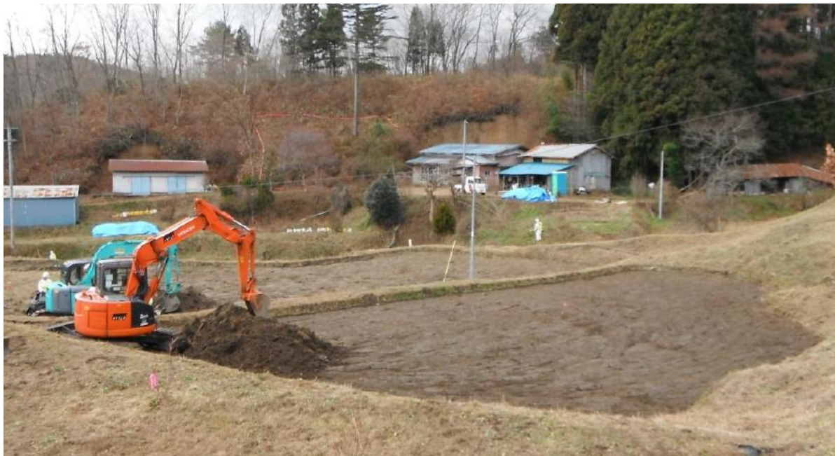
Obr. 3.10 Odstranění horní vrstvy půdy pomocí bagru (zdroj: report (Miyahara et al., 2013))
