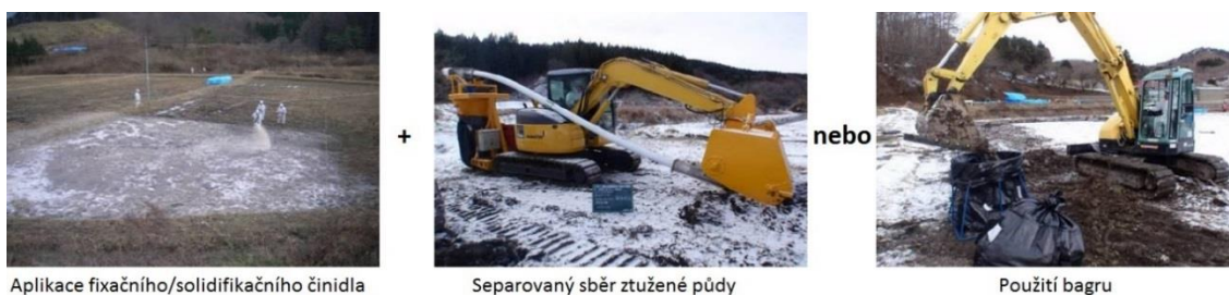
Obr. 3.11 Aplikace fixačního/solidifikačního činidla (zdroj – report (Ito, 2012))
