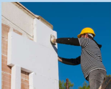
Obr. 5: Zateplení domu polystyrenem
