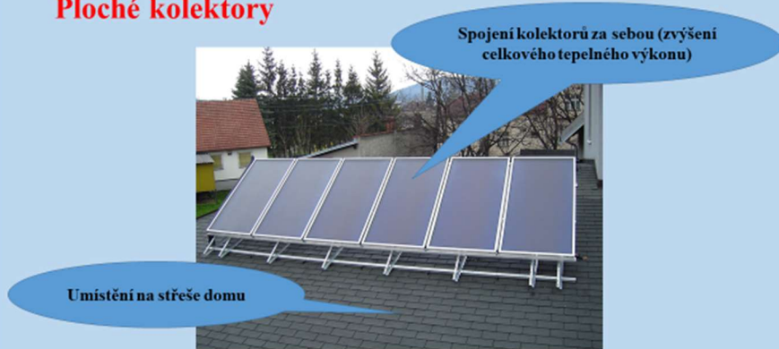
Obr. 4: Spojení kolektorů za sebou
