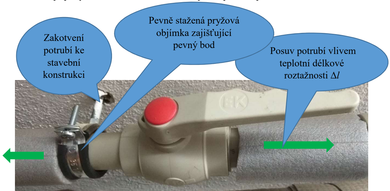
Obr. 7.8: Objímka s pryžovou vložkou na potrubí
