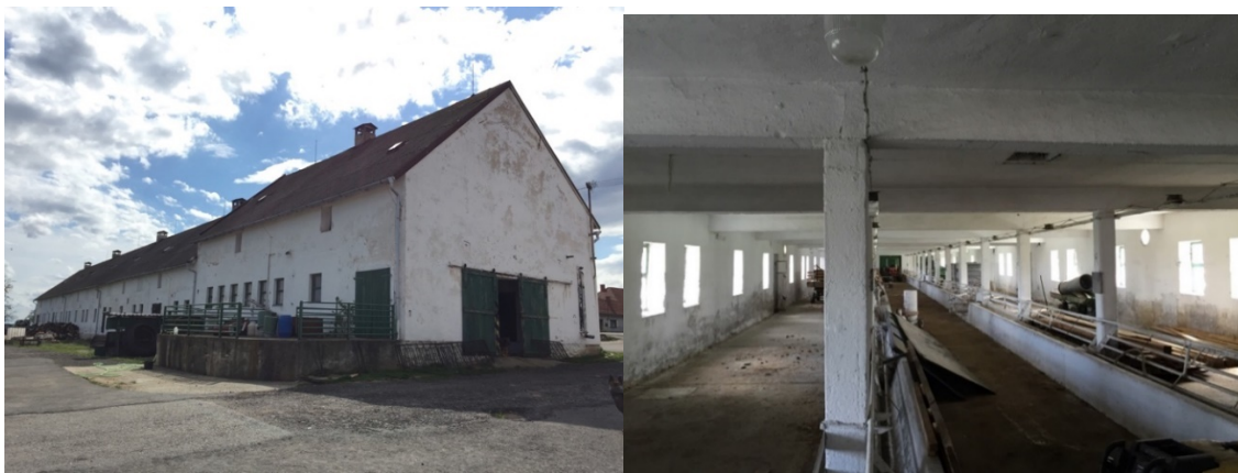
Obr. 19: Současný stav objektu
