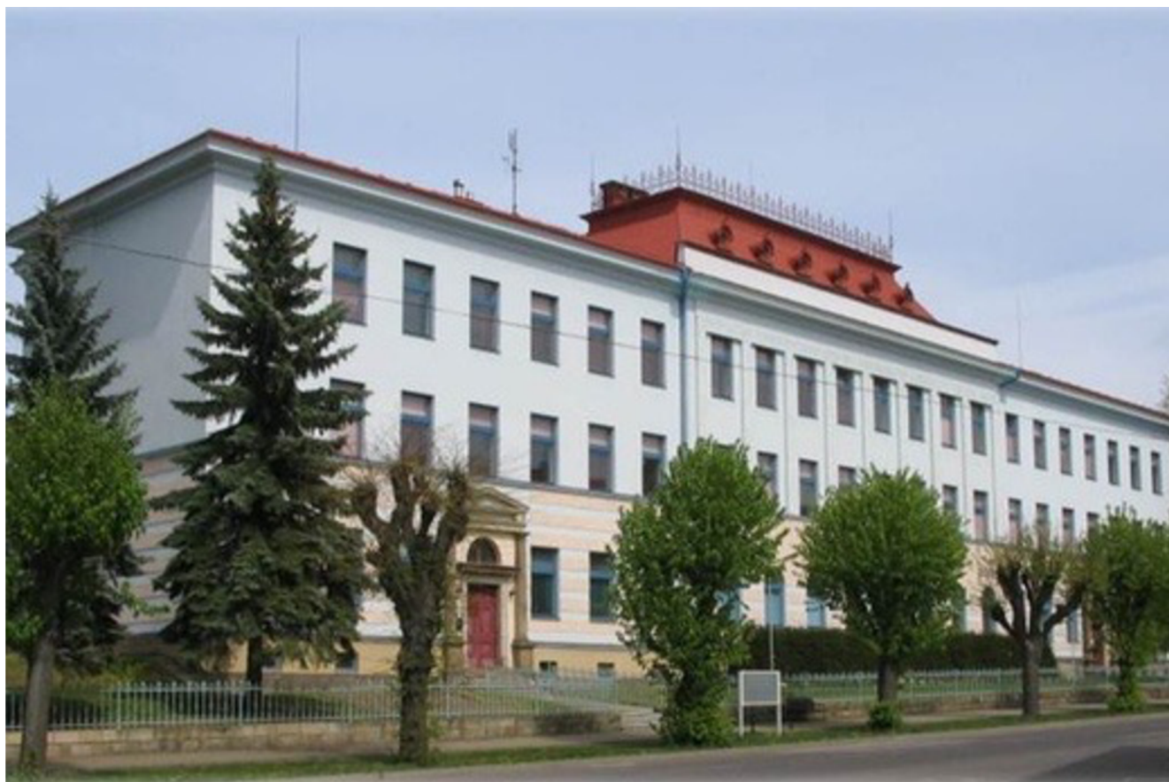
Obrázek č. 2: Budova školy po rekonstrukci z roku 1999
