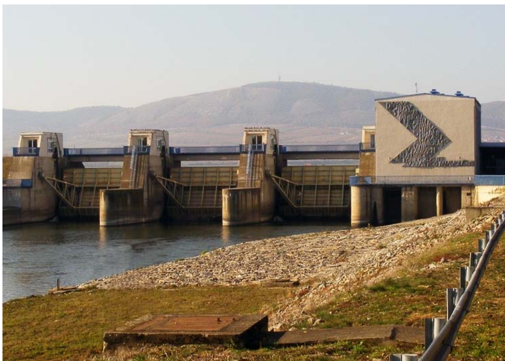
Obr. 8: Výpusť na hrázi Novomlýnské nádrže s vodní elektrárnou, v pozadí Pavlovské vrchy (foto: autorka 12. 11. 2011)
