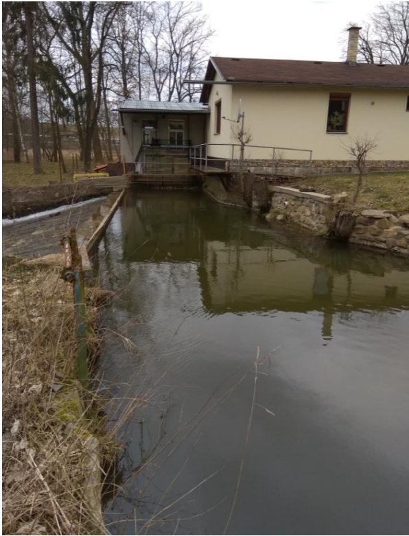
Obr. 4.3 Foto jezu [vlastní zdroj]
