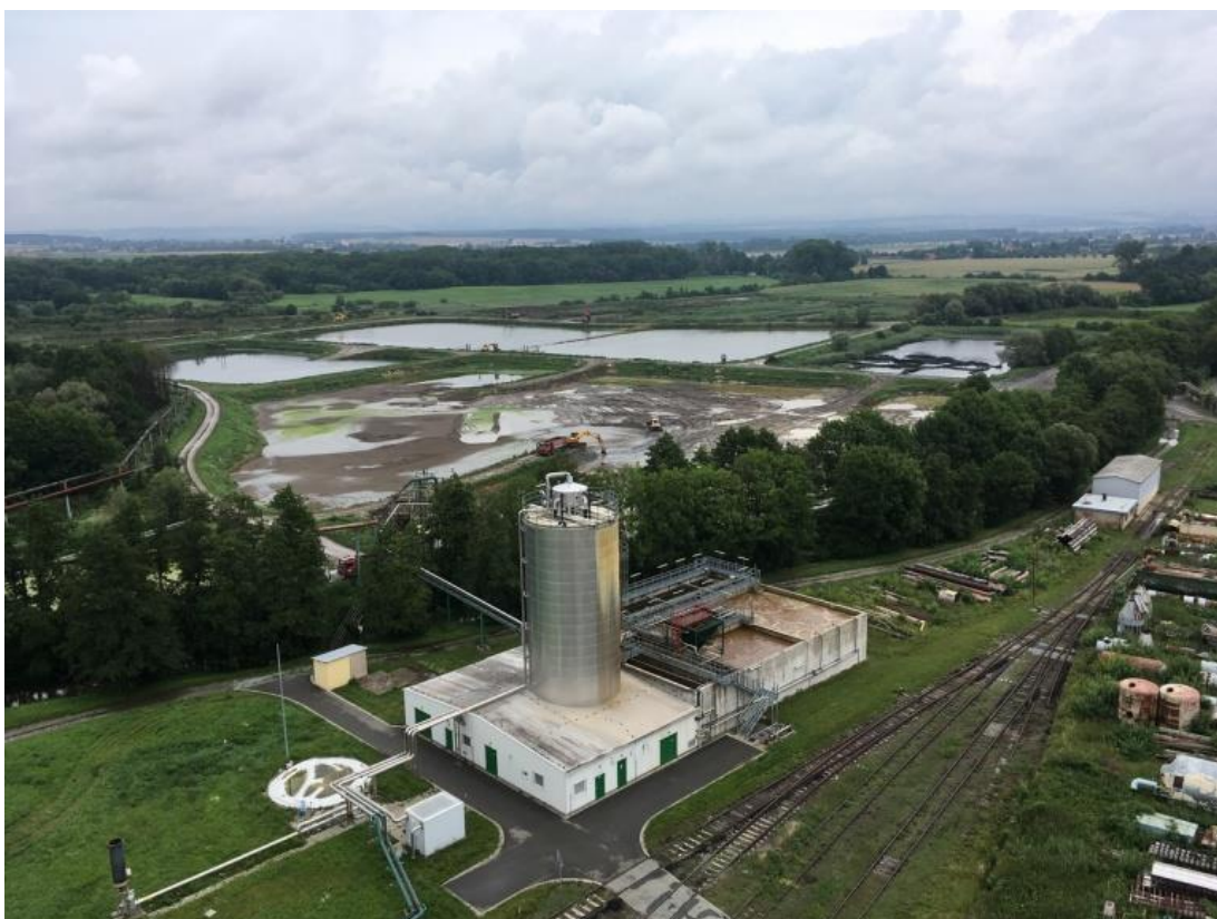
Obr. 1: ČOV České Meziříčí (zdroj: vlastní, 2019)
