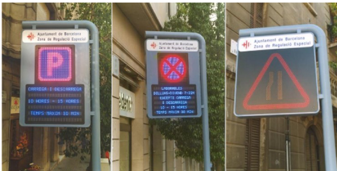
Obr. 2.4 Řízení provozu ve víceúčelových jízdnicích, Barcelona Zdroj: [35].
