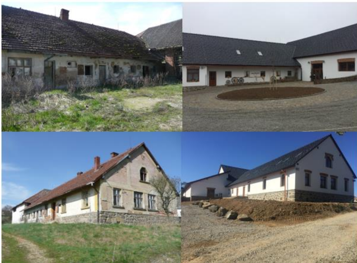
Obrázek 2 farma před a po rekonstrukci
