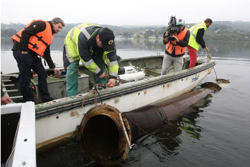
Obrázek 10: Demontace aerační věže (g.denik, 2012)
