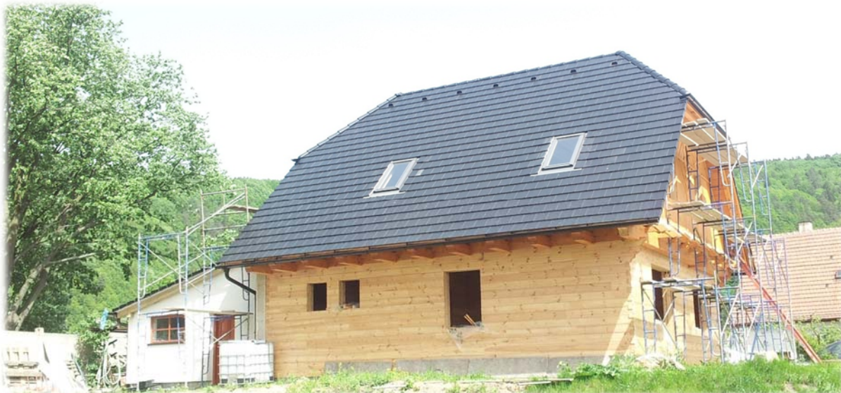
Obr. 22 Fotografie dřevostavby (datum pořízení snímku - 19. 5. 2013)
