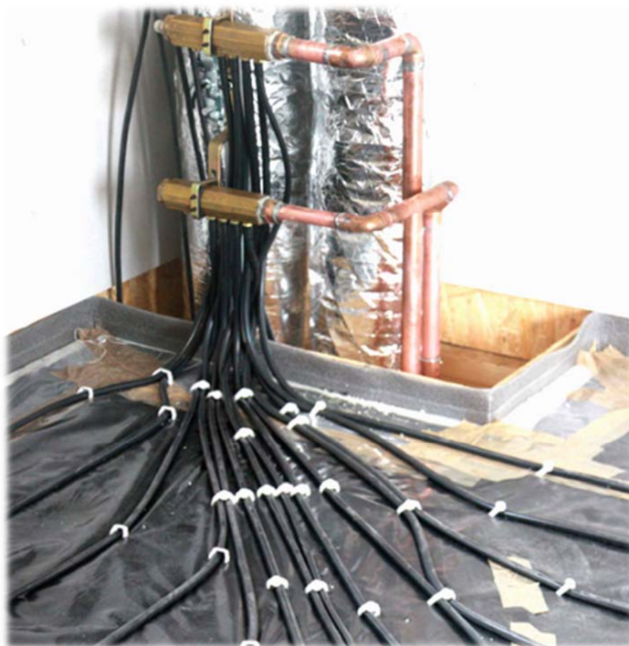
Obr. 29 Napojení potrubí OptiFlex na rozdělovač OptiSplit [24]
