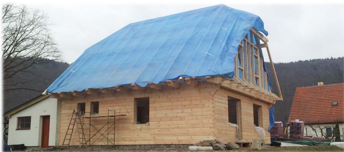
Obr. 21 Fotografie dřevostavby (datum pořízení snímku - 8. 4. 2013)
