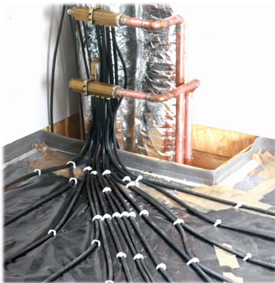
Obr. 29 Napojení potrubí OptiFlex na rozdělovač OptiSplit [24]
