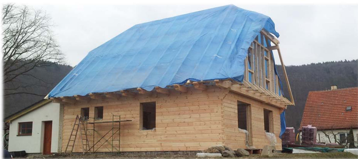
Obr. 21 Fotografie dřevostavby (datum pořízení snímku - 8. 4. 2013)
