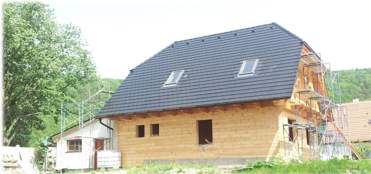
Obr. 22 Fotografie dřevostavby (datum pořízení snímku - 19. 5. 2013)
