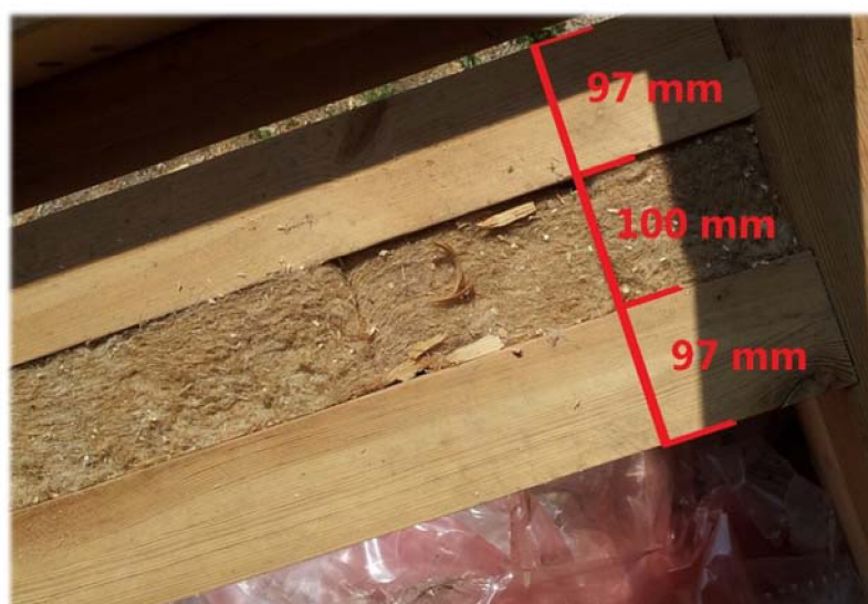
Obr. 23 Detailní pohled na roubení 1. NP včetně konopné izolace
