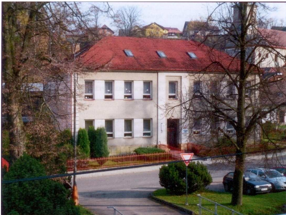
Budova ZŠ před rekonstrukcí
