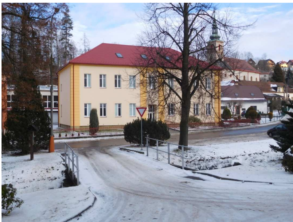
Budova ZŠ po rekonstrukci
