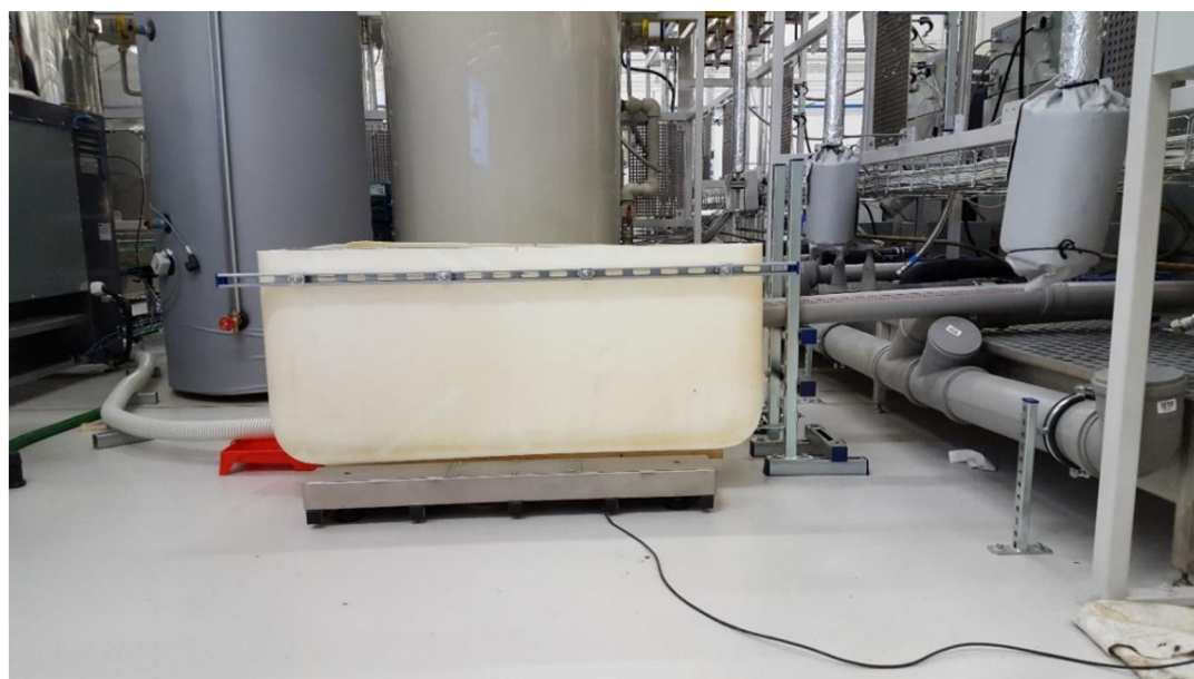
obr. 5-8: Pohľad z boku na výtok z práčky, nádrž a jej odtok
