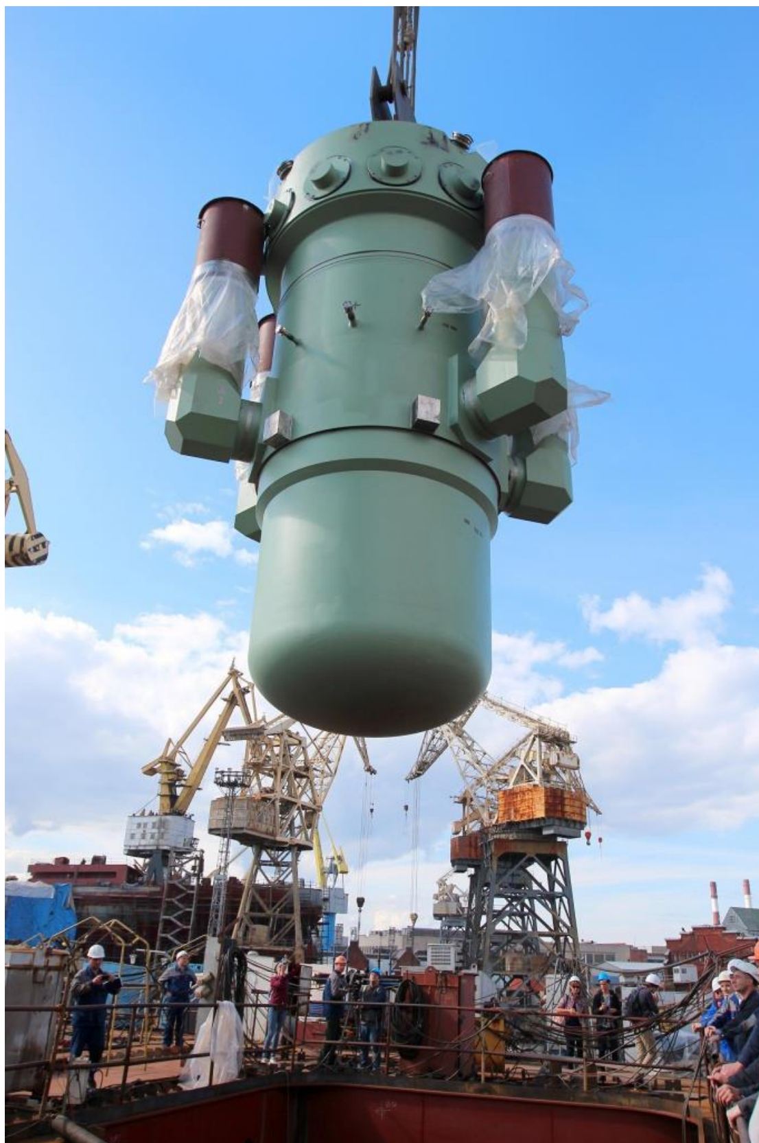
Obrázek 92: Ukládání reaktoru RITM-200 do ledoborce Arktika
