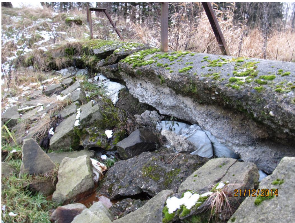
- Vzdušná strana bezpečnostního přelivu, 2014
