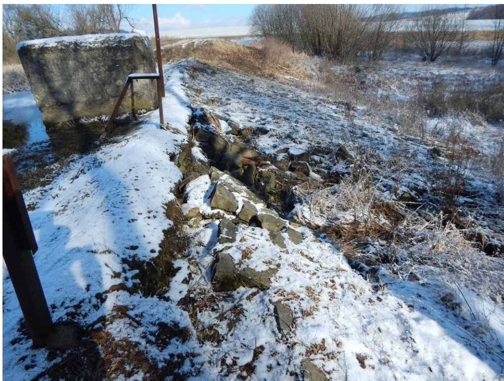
- Bezpečnostní přeliv s požerákem, 2016
