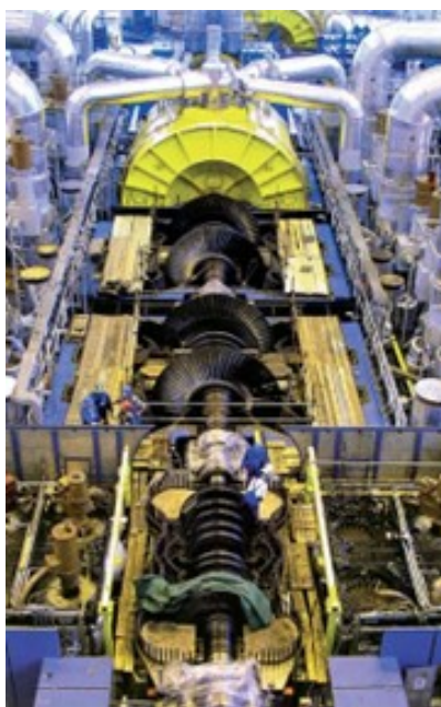
Obrázek 1.4: Parní turbína v jaderné elektrárně (pinterest.fr, 2023)
