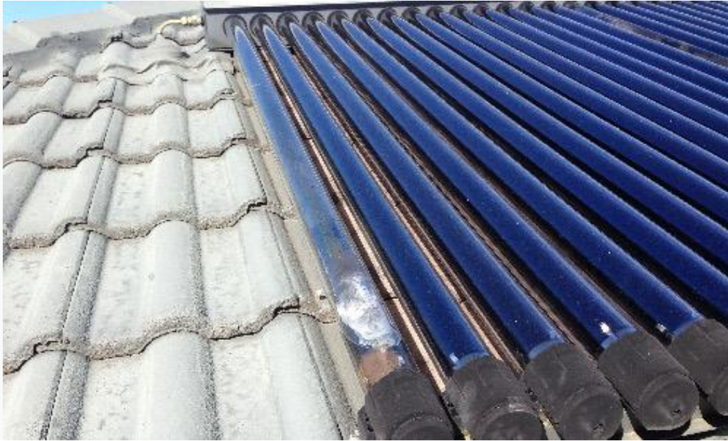
Obrázok 1. 10 – Poškodená trubica vplyvom krupobitia [13]
